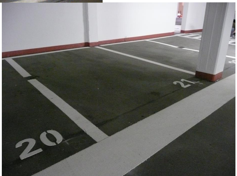
Zustand nach Abschluß der Sanierungsarbeiten
