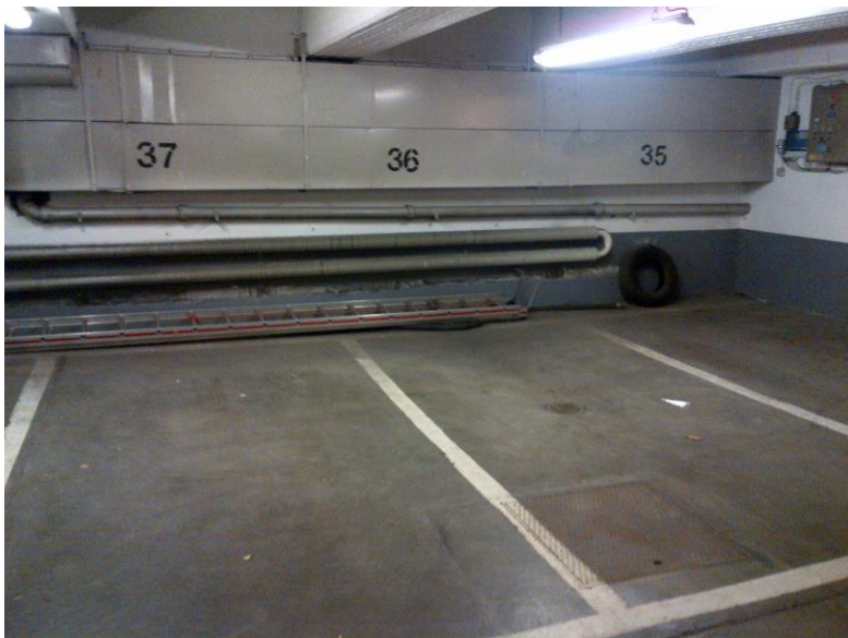
Zustand vor der Sanierung
