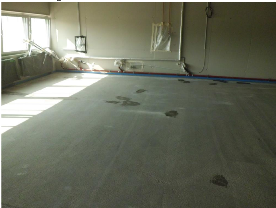
Untergrundbeschaffenheit nach Estricharbeiten
