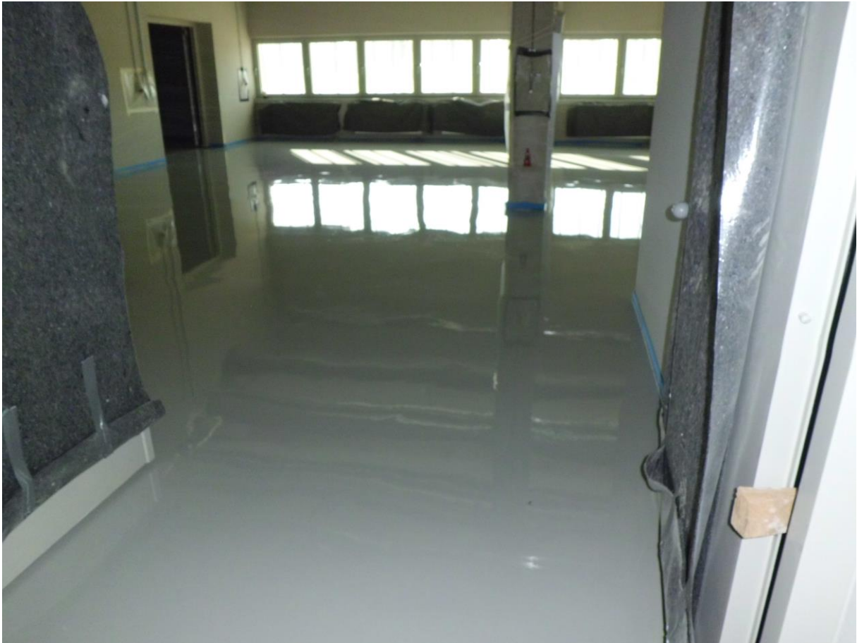
fertig beschichteter Fußboden
