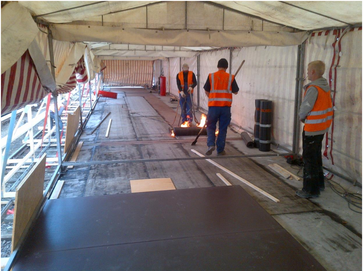
Abdichtungsarbeiten mit Bitumenschweißbahnen
