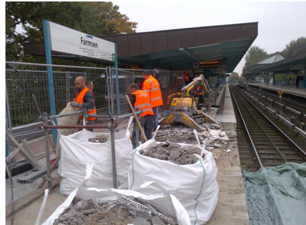
Betonabbruch des vorhandenen Belags
