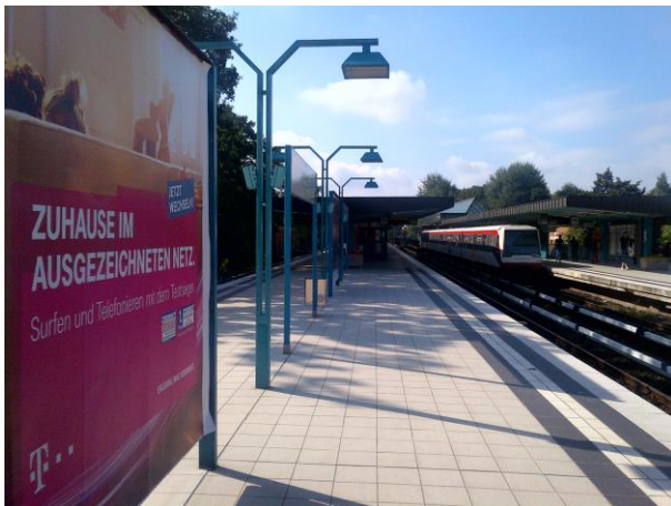
Zustand vor Beginn der Bauausführung
