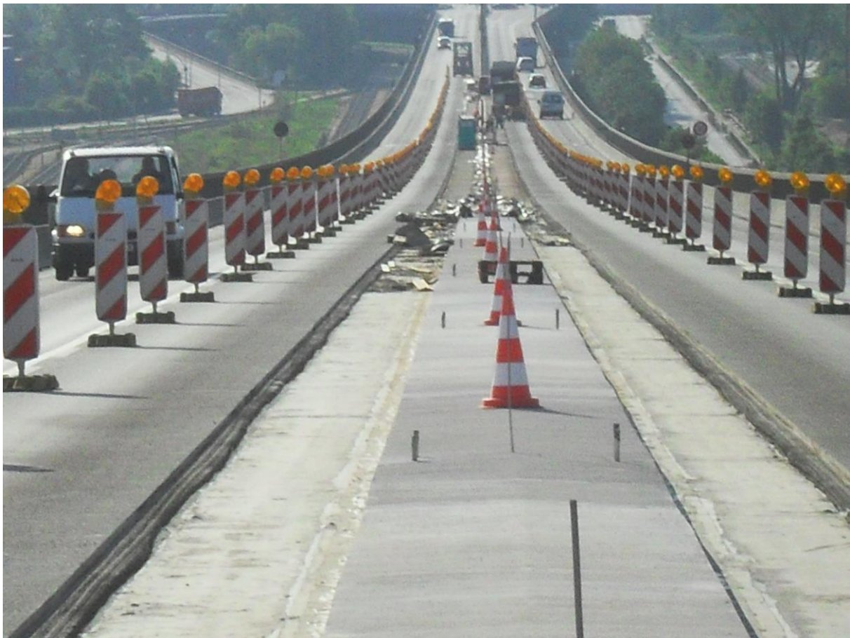
Betonsanierung unter halbseitiger Fahrbahnspernung
