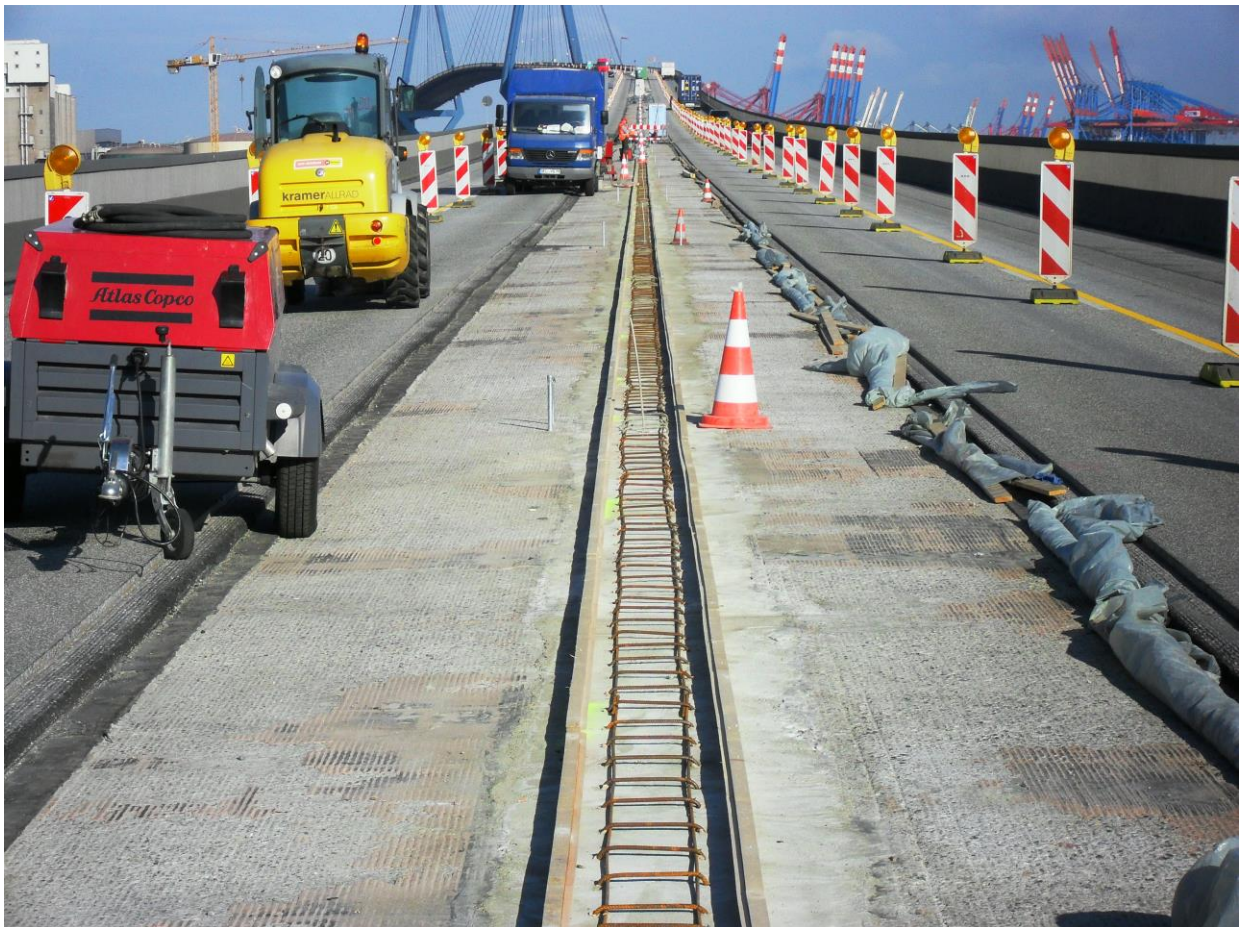
Sanierung der Mittelkappe - Betoninstandsetzung
